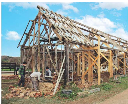
Restauration d'un charnil du 19 ème siècle
